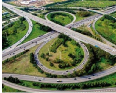
도시고속도로 연결램프(00로 진출입) 건축공사
