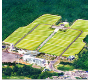
국립00호국원 제3봉안당 건립공사 건축공사 기초금액 17,823,770,000
